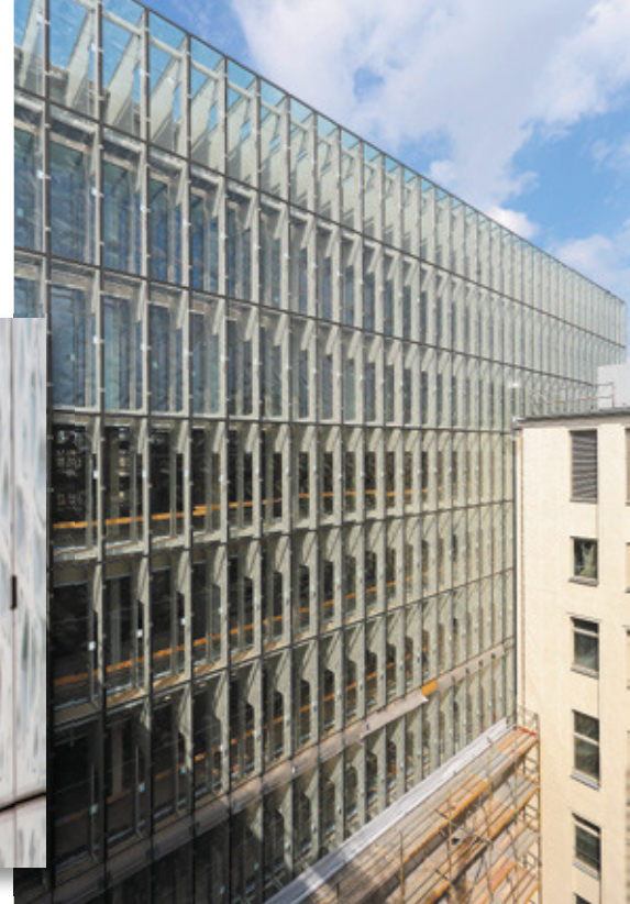
Mit der grossen Fensterfront lässt sich das Tageslicht optimal nutzen.
